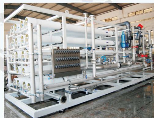
▶ 150 M 3 /H RO单元设备
